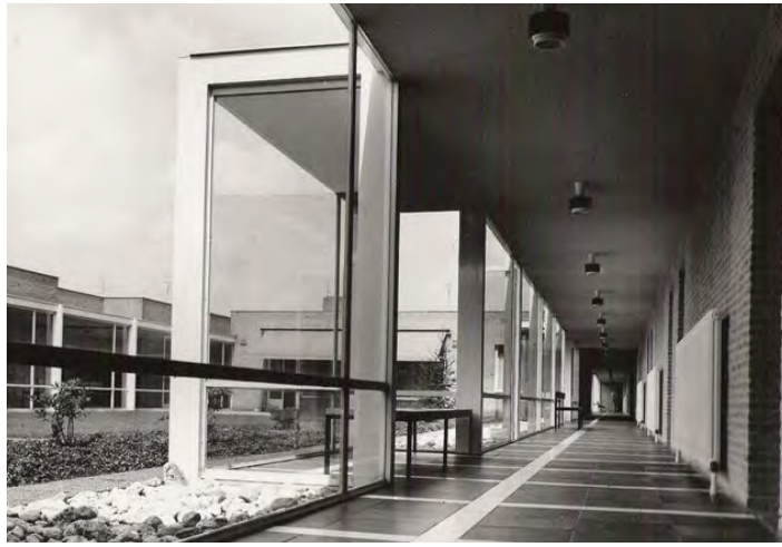
GGD Ringbaan West 227, 1962-1967
