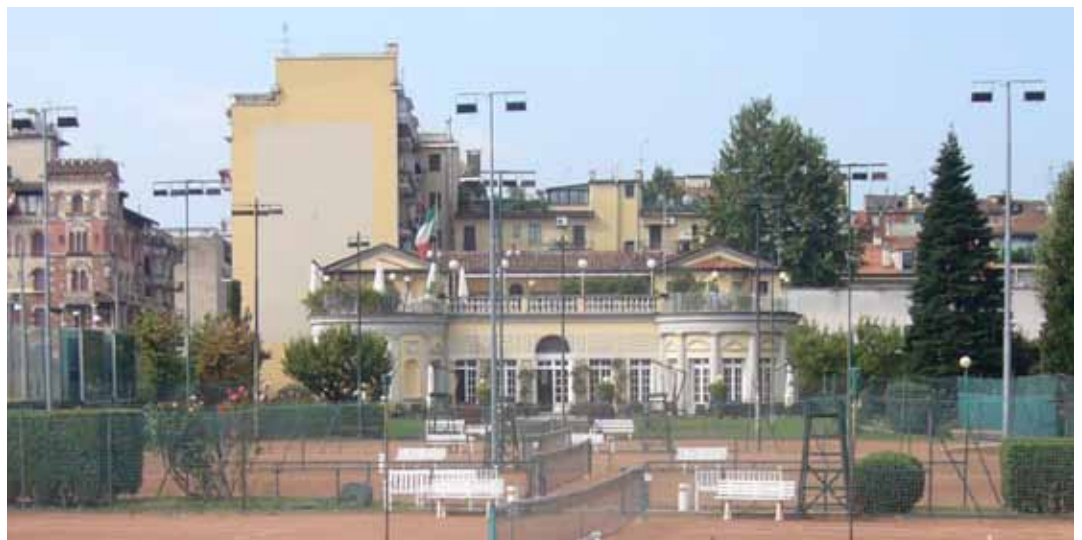
Palazzina, Tennis Club Milano Alberto Bonacossa 1923
