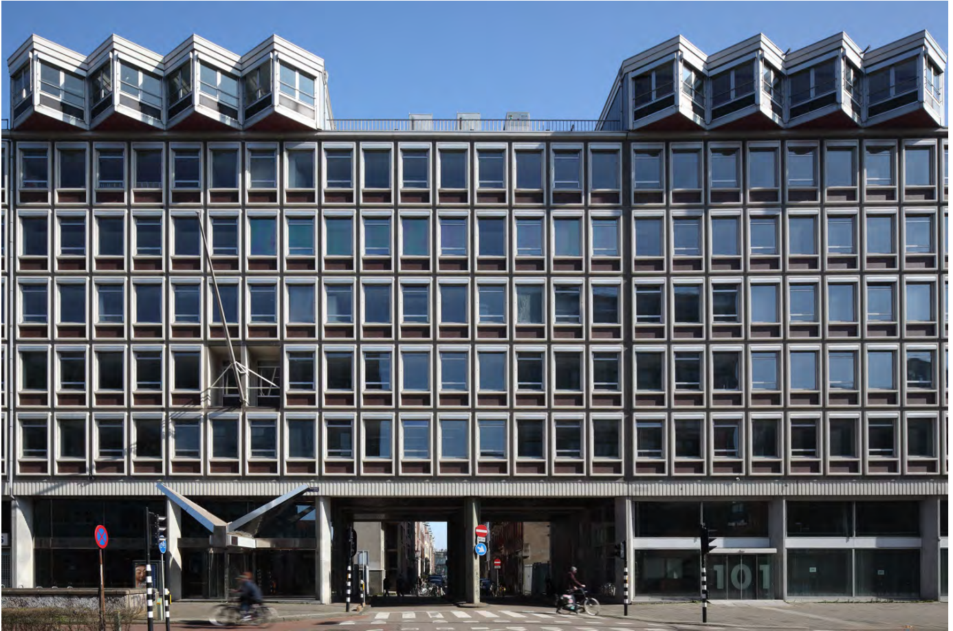
Underpass at the level of the Nieuwe Kerkstraat. Image: Bart van Hoek (2016).
